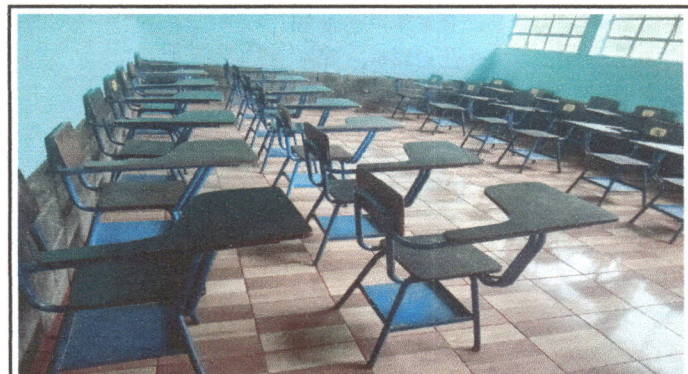
Foto 4: Mejoramiento de piso de concreto a piso cerámico de 33*33 en aulas 1 y aula 2
