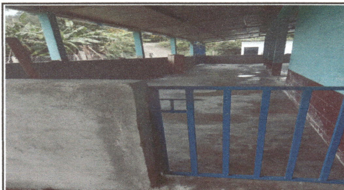
Foto 3: Reparación de piso de tierra a piso de concreto alisado natural en área de corredor. Con baranda de 4 hiladas de block en el perímetro del corredor.
