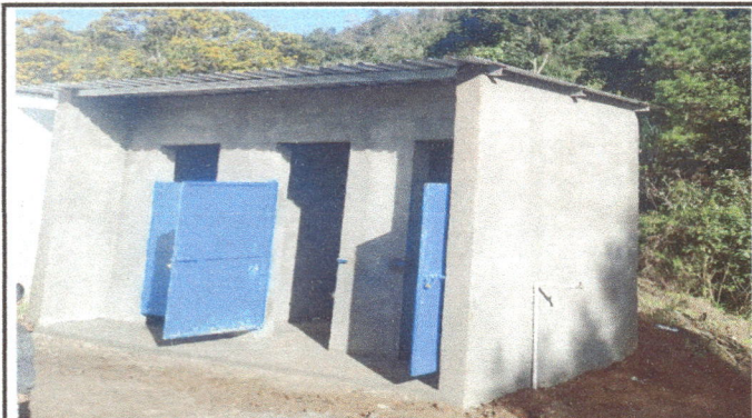
Foto 1: Mejoramiento de paredes a blocks de los baños, columna, cambio de letrina a inodoro, cambio de techo a lamina troquelada, costanera, tubería de drenaje a fosa séptica. Sustitución de 3 puertas a metal.
