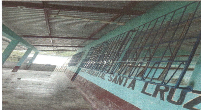
Foto 2: Reforzamiento de ventanas con balcón de 2*2m en todo el corredor de la escuela, áreas de dirección y bodega, para resguardo de aparatos tecnológicos de FUNSEPA (tablet)
