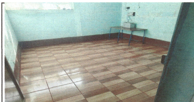
Foto 5: Mejoramiento de piso de concreto a piso cerámico de 33*33 en área de bodega y dirección.
