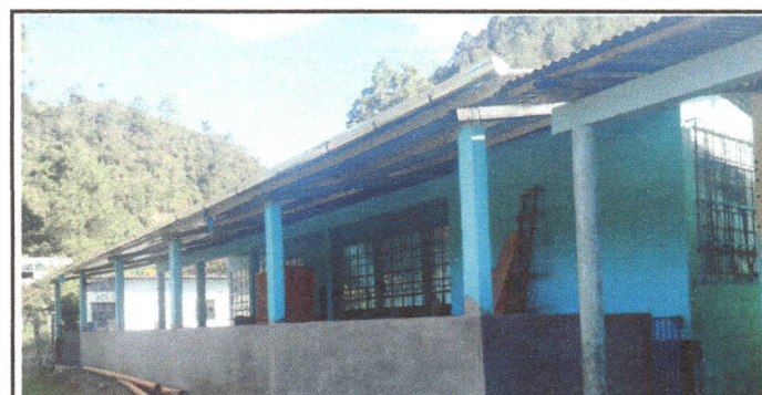
Foto 6: Sustitución de canal a canal de metal con baja de agua pluvial. Colocación de portón en entrada principal.
